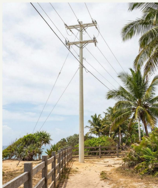
Poste FRP instalado em ambiente costeiro tropical — sem corrosão, 15 m
