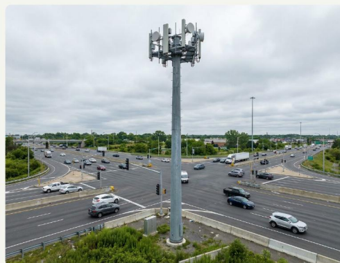
Monopolo cônico 25 m em interseção de rodovia
