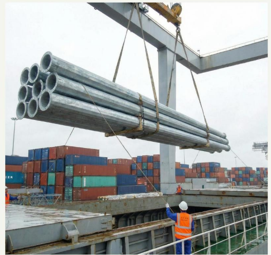
Carregamento de seções de torre em navio de carga fracionada (Breakbulk) — Porto de exportação, China
