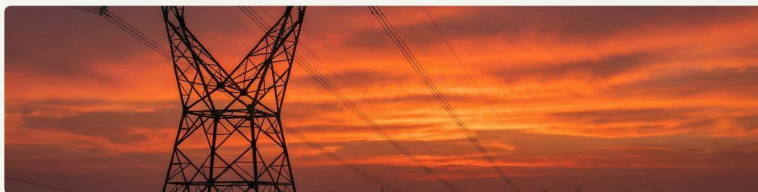
Torres de Transmissão Elétrica — Págs. 7–11
