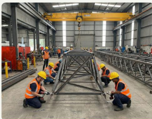
05 Montagem de Teste
