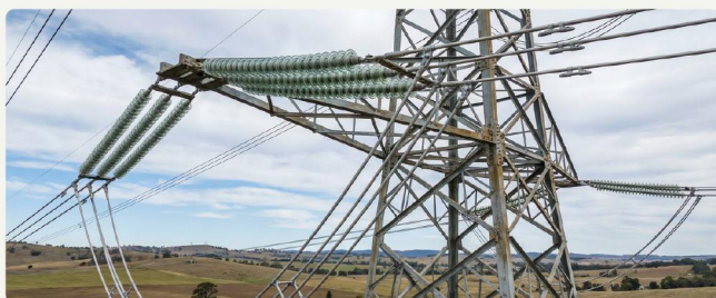
Tour d'Angle / Ancrage — changement de direction
