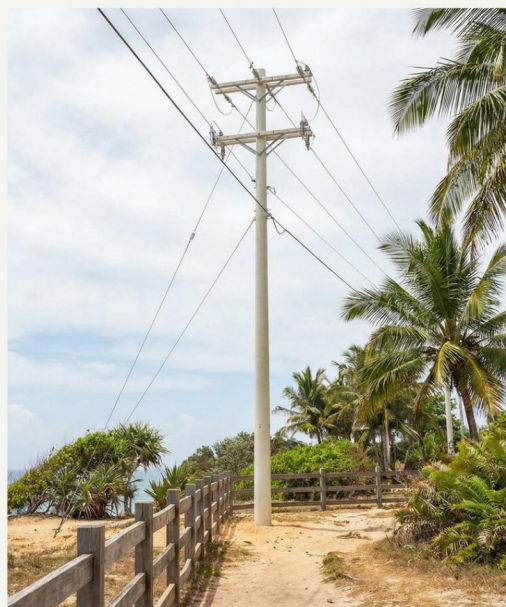
Poteau FRP installé en milieu côtier tropical — sans corrosion, 15 m
