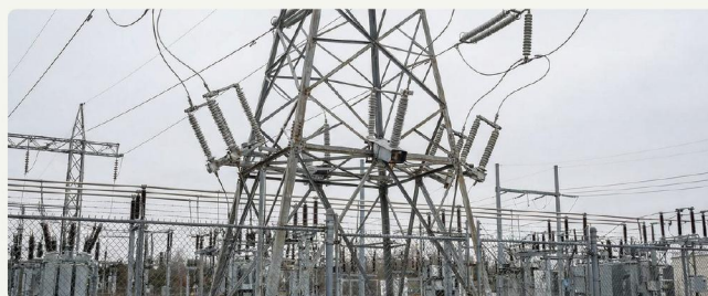
Tour Terminale (Dead-End) — terminaison en sous-station
