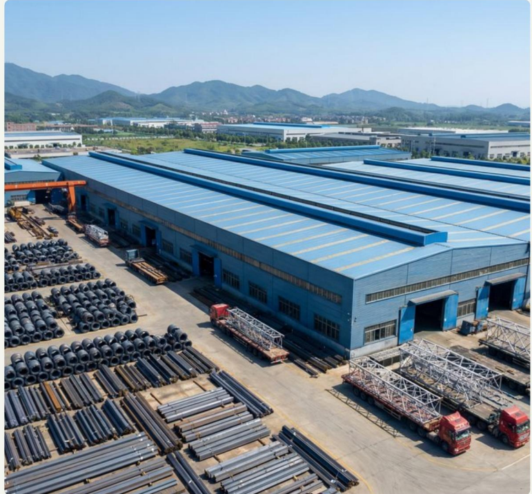
Planta de fabricación SOLARTODO — 50.000 m 2 , China
