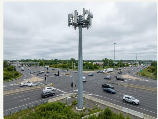
Monopolo cónico 25 m en intersección de autopista
