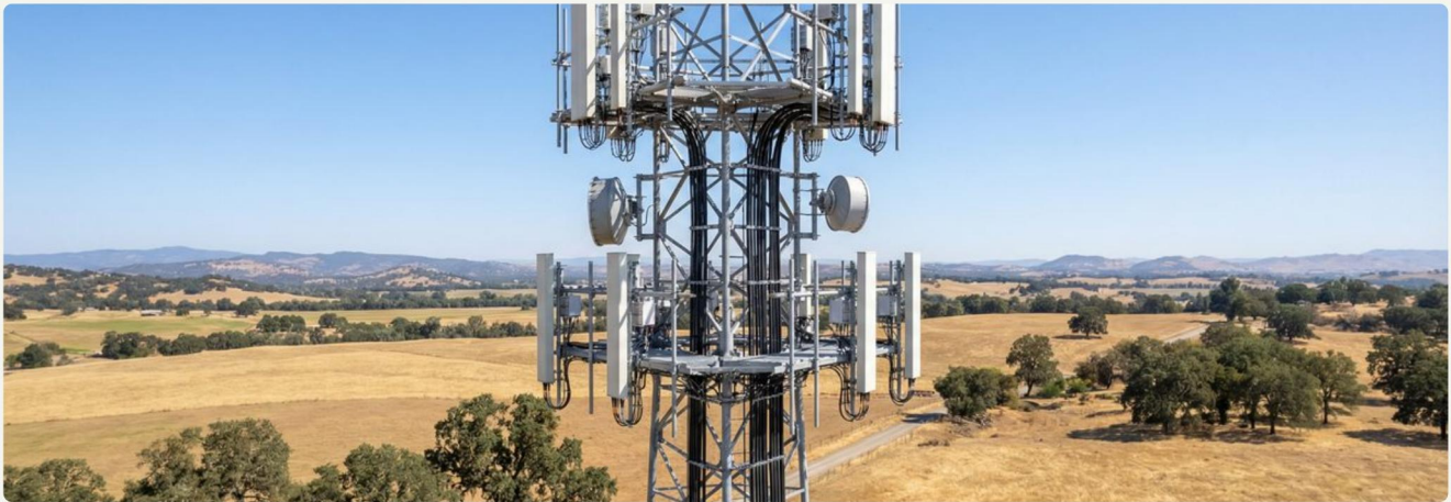
Torre autoportante cuadrada 60 m — plataformas 3-sector, luz de aviación, 5G Ready
