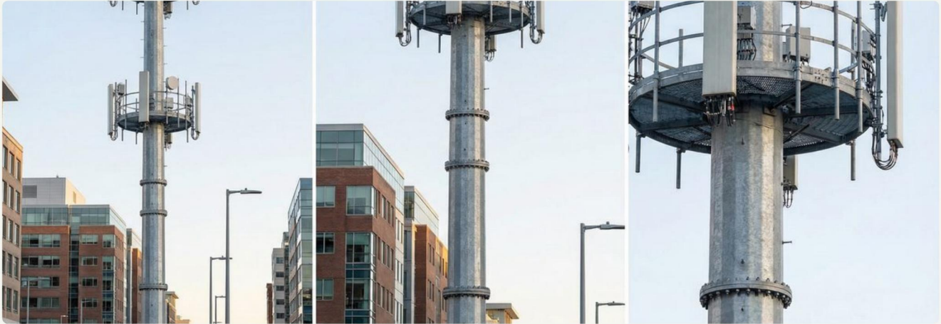
Monopolo por secciones con brida 35 m — 3 plataformas de antenas, galvanizado en caliente
