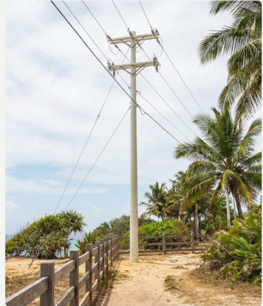
Poste FRP instalado en entorno costero tropical — sin corrosión, 15 m
